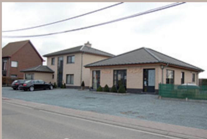
Frituur de Linde, achteraf bijgebouwd bij de bestaande woning annex kapsalon
